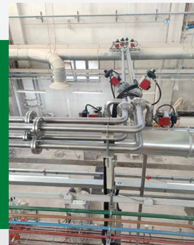
Valvole di scarico • Discharge valves • Válvulas de descarga • Vannes de déchargement • Válvulas de descarga.
