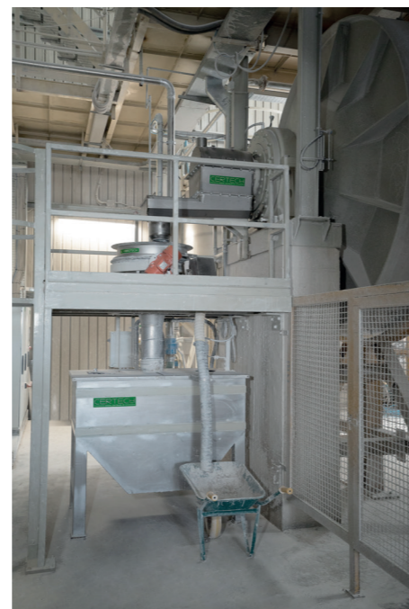
Scarico primo modulo con setaccio sghiaiatore e vasca di trasferimento barbotina. Unloading of the 1st module by means of a sediment excluding sieve and slip transfer tank. Descarga del 1er módulo por medio de un tamiz desarenador y tanque de transferencia barbotina. Déchargement du 1er module à travers d'un tamis dégraveur et cuve de transfert barbotine. Descarga do primeiro módulo com crivo para eliminar sedimentos e tanque de transferência barbotine.
